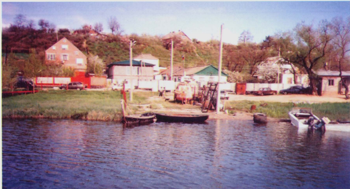
Рис. 20. Вид с берега на строящийся корпус здания рыбоводного комплекса
