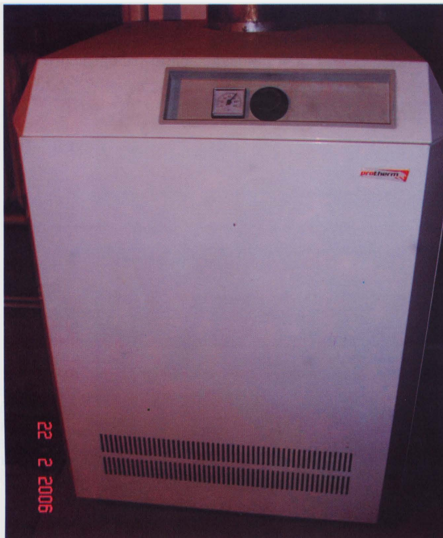
Рис. 29. Газовый котел Protherm 50 TLO
