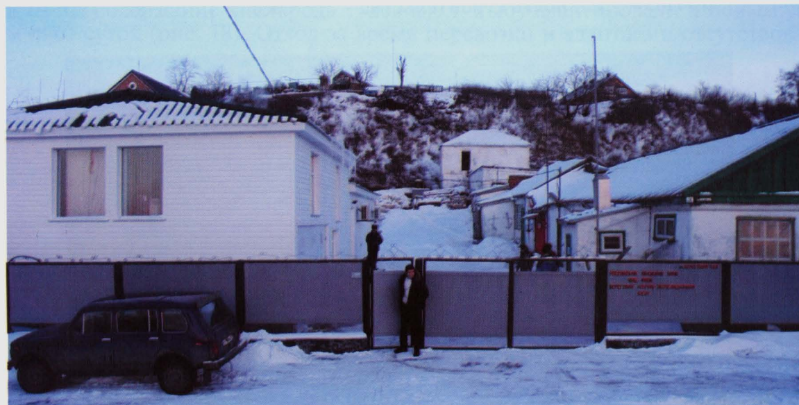
Рис. 21. Здание рыбоводного комплекса «Кагальник»
