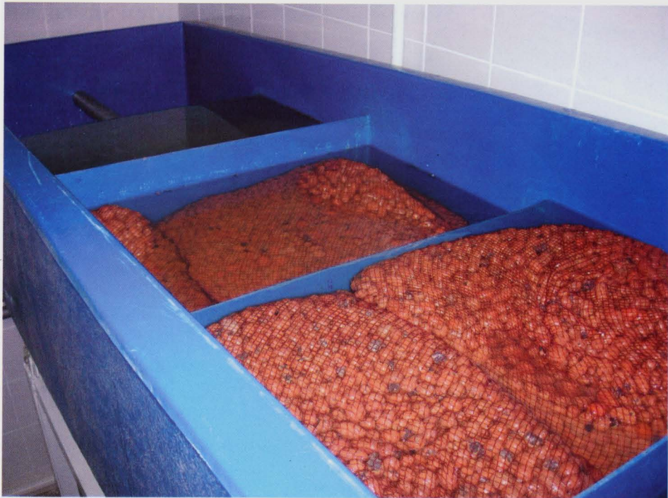
Рис. 33. Биофильтр с керамзитным наполнителем
